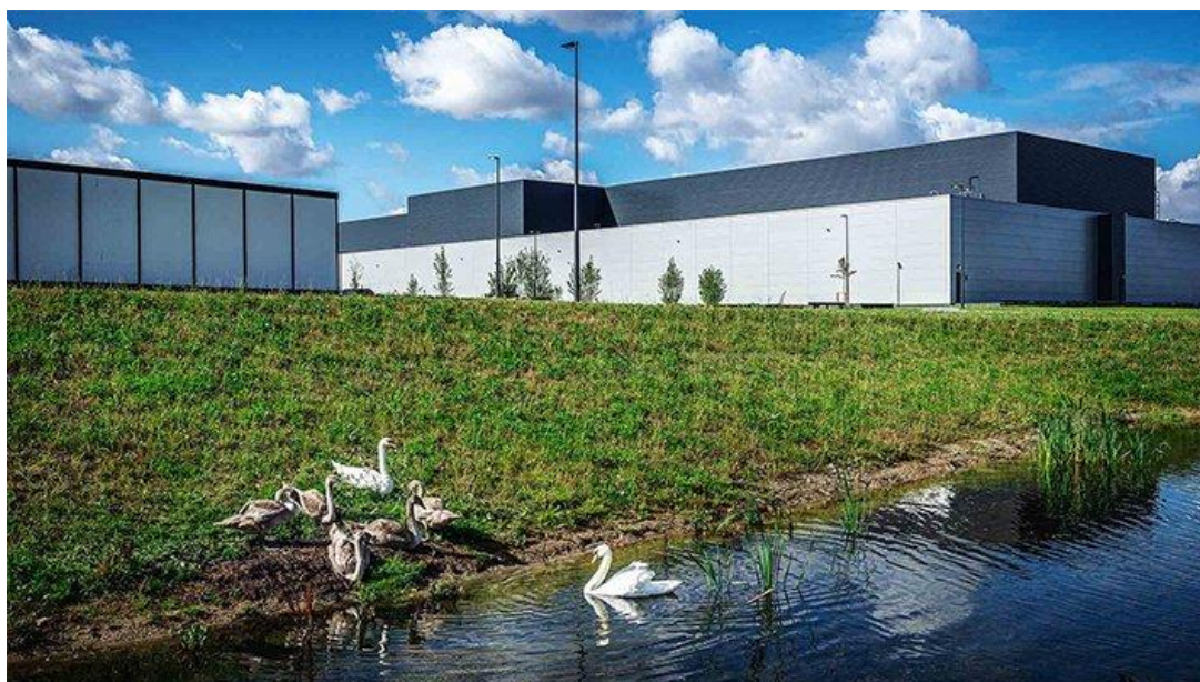
Datacentret i Odense.
