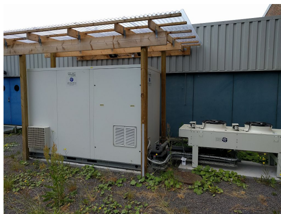
Køkkenkølekompressorenhed (foto: Per Nørgård, 2018).
