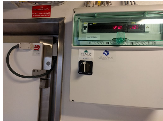
Den lokale styringsenhed af temperaturen i Kølerum 1 (foto: Per Nørgård, 2018).
