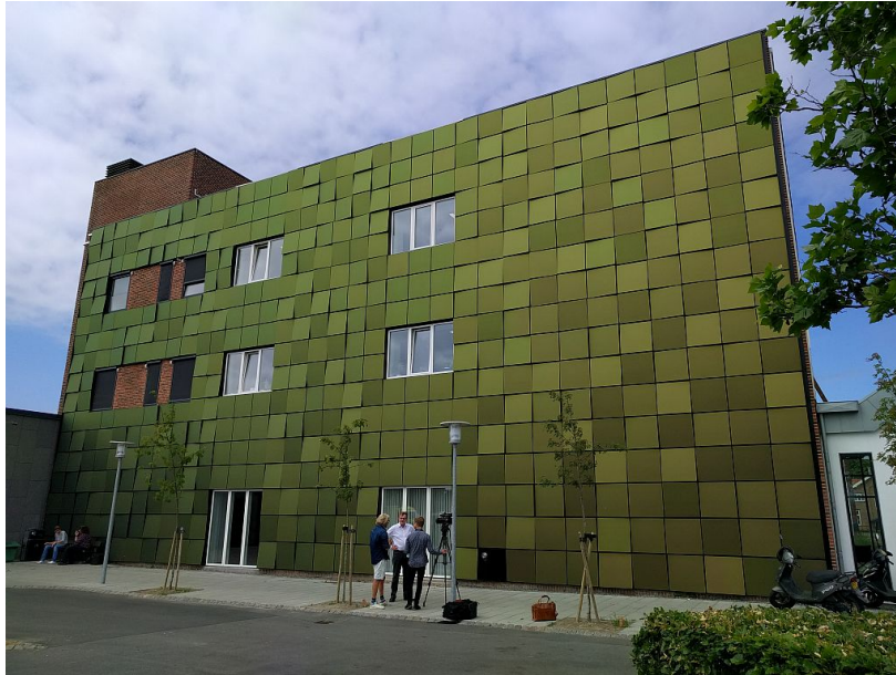
Soleceller på gavlen af hovedbygningen på Bornholms Hospital (foto: Per Nørgård, 2018).
